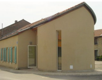
La nouvelle salle communale
